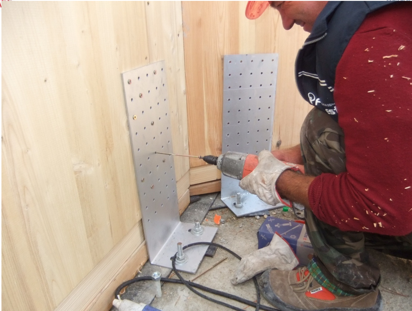
FISSAGGIO PANNELLI VERTICALI
